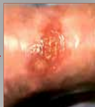
Imagen 3: 19/12/19. Lecho totalmente limpio y granulado.
